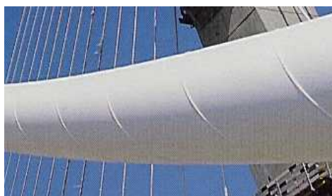
3. ábra Spirális vízvezető horony a burkolócső palástján
